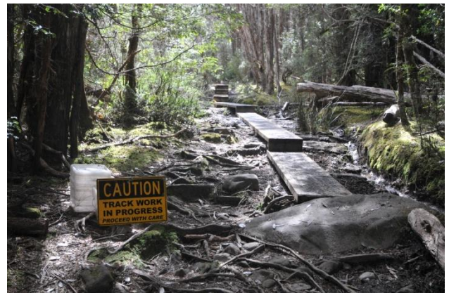
Muddy な場所では着々と木道工事中。昔よりは随分歩きやすくなったようだ。
