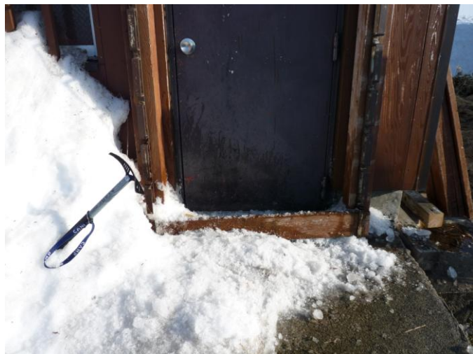
横木を上からは外して行ったが、最後の1本は雪が凍りついて外れない。この横木のせいでドアが開かず、中には入れない。ピッケルで雪を削って、中に入るまでに1時間もかかってしまった。
