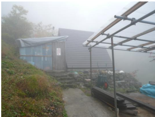
赤倉温泉源泉管理小屋。横に水場もある。
