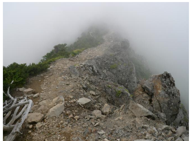
西側が崩れて切れ落ちている
