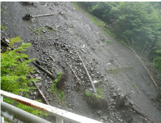
大根沢橋の崩壊地
