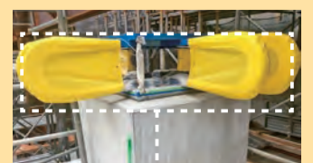
鋼材ダンパー ・地震による建物の揺れをゆっくりにする
