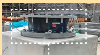
天然ゴム系積層ゴムアイソレーター ・鉛直力(建物の自重)を支える ・地震による建物の揺れをゆっくりにする
