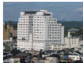
【平成22年に完成した高層棟】
