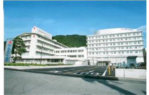
昨年10月に竣工した新病院
