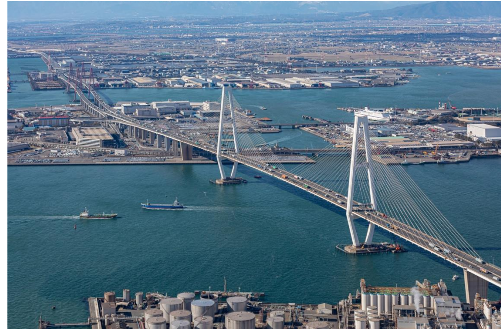
Nagoya Port 名古屋港
