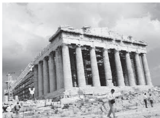
写真5. 工事中のパルテノン神殿
