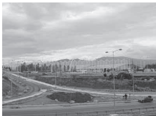
写真6. オリンピック会場 ただいまのんびり工事中
