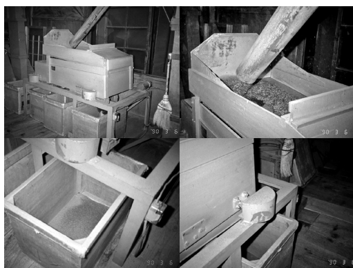
図2：製茶工場内に設置されていた製茶機（選別機）。緑茶が送り込まれてふるいにかかけられると細かい粉塵が周囲に散乱し，機械と周辺に蓄積していた。
