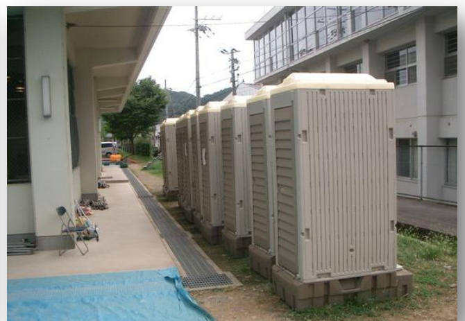
ボランティアセンター内の仮設トイレ
