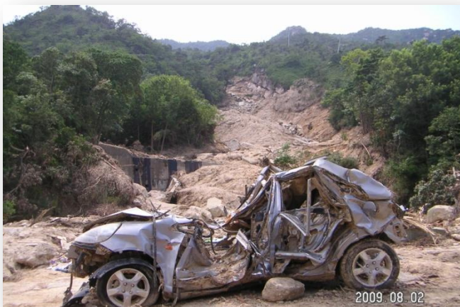
下右田地区の土砂崩れ被害
