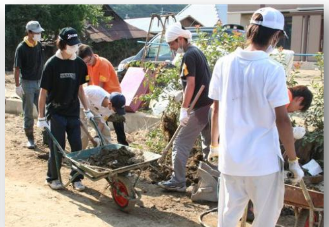
粉塵舞う中の泥だし作業
