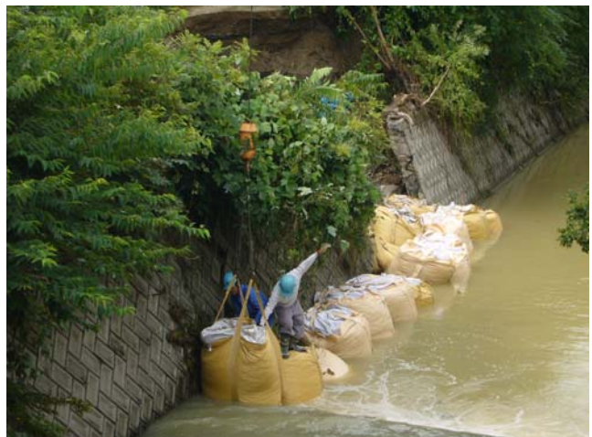
護岸の応急補修（栄町・大平町）
