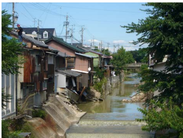
被害を出した伊賀川
