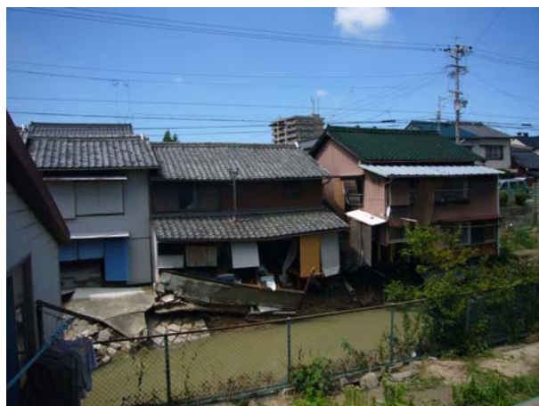
水が流れ込んだ川沿いの家屋
