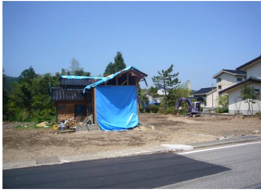
解体後更地となった様子
