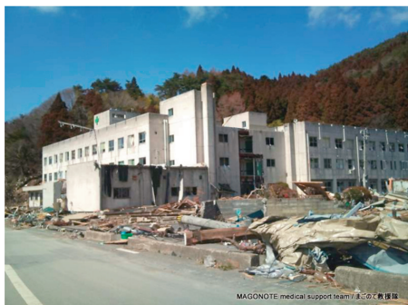
1. 全壊し、職員ほぼ全員が犠牲となった石巻市立雄勝病院。
