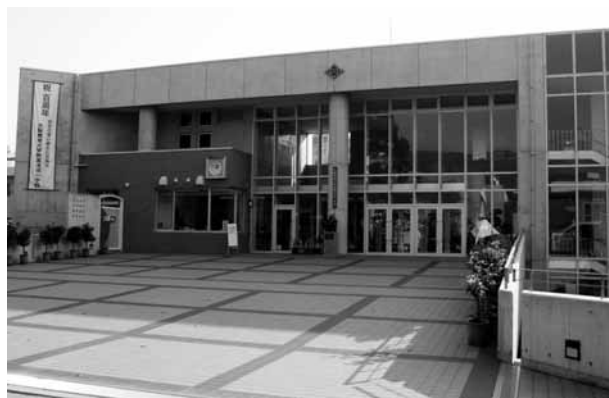
写真2 附属池田小学校の玄関
