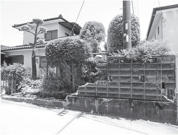
写真2 倒壊したブロック塀
