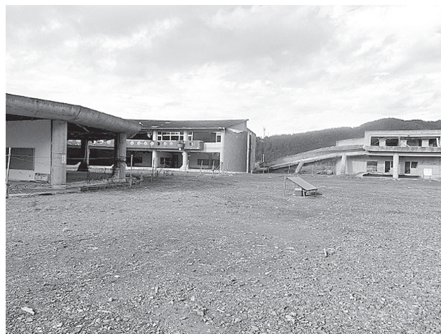
写真1 津波被災後の大川小学校
