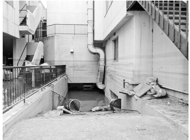
写真1 地下部分が冠水した病院施設
