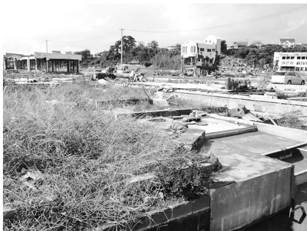
写真2 石巻市内の津波被害
