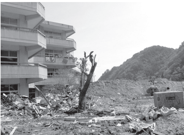
写真2：釜石市立釜石東中学校（平成23年5月）
