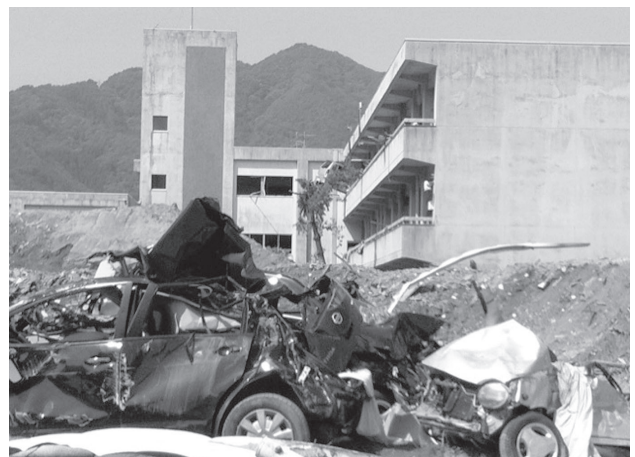
写真5：釜石市立鶴住居小学校（平成23年5月）
