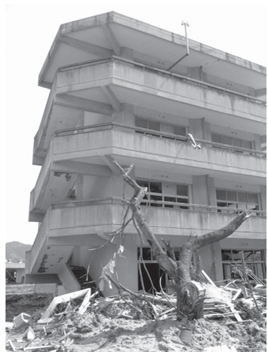
写真4：釜石東中学校校舎（平成23年5月）
