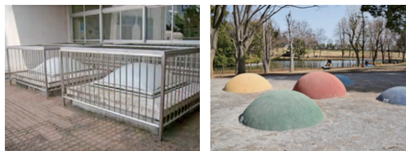
左) 転落防止策が設置された天窓 右) 半球体の遊具
