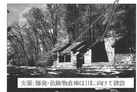
火薬・爆発・危険物倉庫は川に向けて建設
