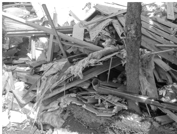
写真2 倒壊建物のむき出しになった建築材
