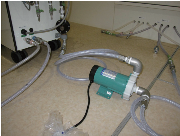
図2 加圧ポンプ装着後
