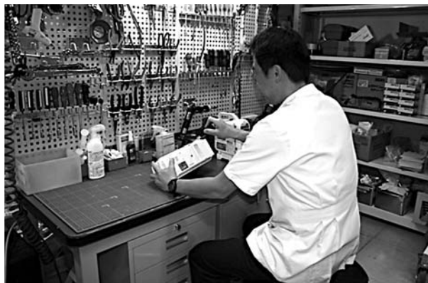
図2 ポンプ点検中
