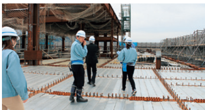
屋上です。板の下は…
