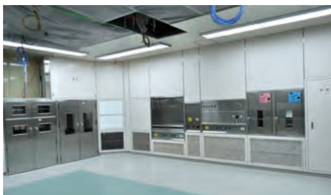
▲バイオクリーンルーム
