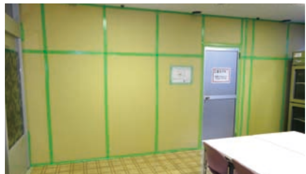
▲厨房エレベータ改修のため仕切られた病棟ディールーム
