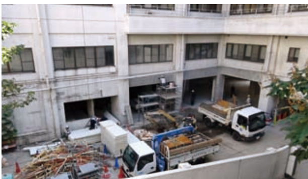
▲厨房に改修される中病棟地下エリア
