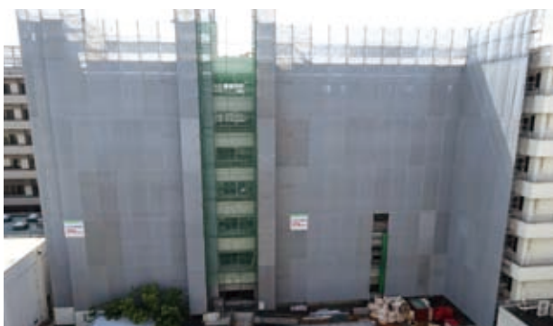
▲外部足場が組立てられた東病棟
