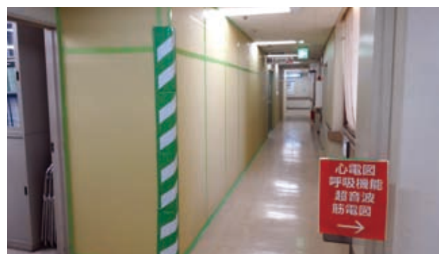
▲仮設間仕切り壁で囲われた検査部エリア
