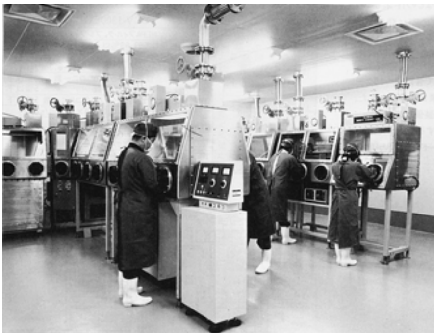
図6 竣工当時(1981年)の国立予防衛生研究所高度安全実験施設(日立バイオハザード対策システム・機器カタログより転載)
