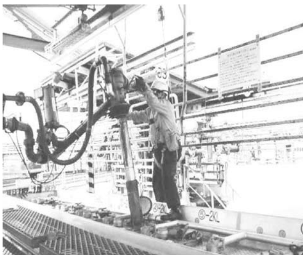
図 補-28. タンクローリーへのガソリン積込み作業（屋外）
