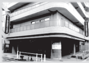
東武練馬中央病院 東京都板橋区徳丸3-19-1
