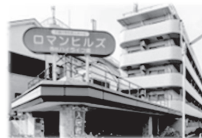
有料老人ホーム ロマンヒルズ西台 ハイライフ 東ケアホーム 東京都板橋区西台3-11-17 南ケアホーム 東京都板橋区西台3-6-3
