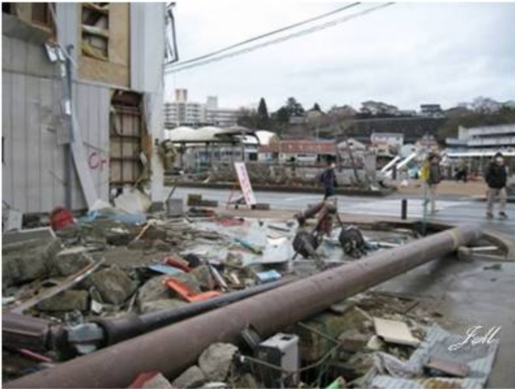
津波で破壊された港の町
