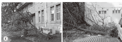
④ 台風 15号による千葉大学医学部構内の倒木
