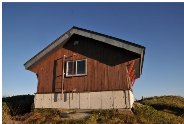
中ノ岳避難小屋は比較的頑丈な作り。良く手入れもされていた。
