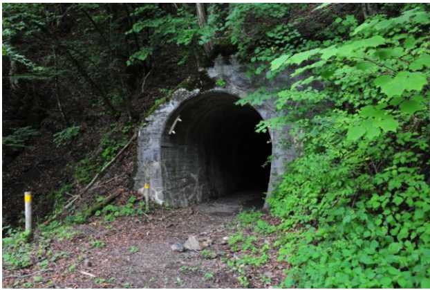
便ヶ島手前のトンネル。
