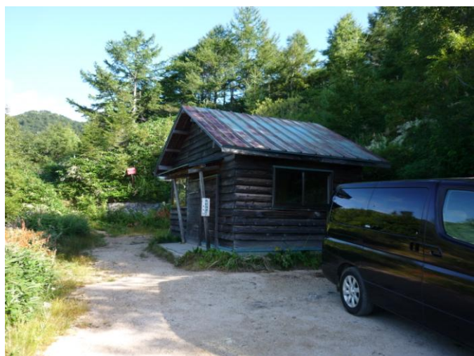
登山口に立つ避難小屋(自然休憩舎)
