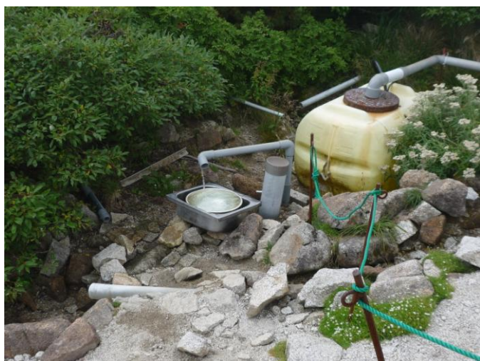
小屋のすぐ近くに、水が豊富に湧き出している
