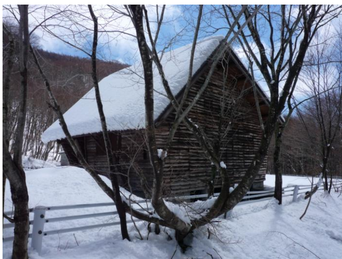
川場谷野営場避難小屋
