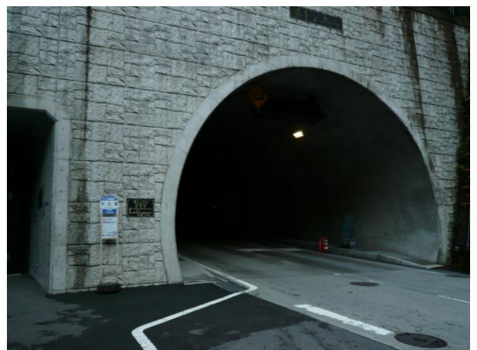
釜トンネル手前の中湯バス停で下車。
