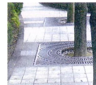
植込みの段差
