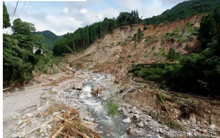
北山地区 崖崩れ・通行不可
