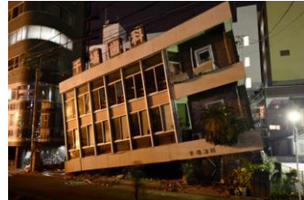
強い地震により一階部分が押しつぶされた歯科医院の建物(16日午前4時、熊本市中央区安政町)＝共同
