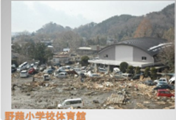
野蒜小学校体育館
